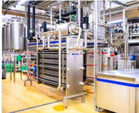
Um Ressourcen zu sparen wurde bei Züger eine Optimierung des CIP-Prozesses umgesetzt.
